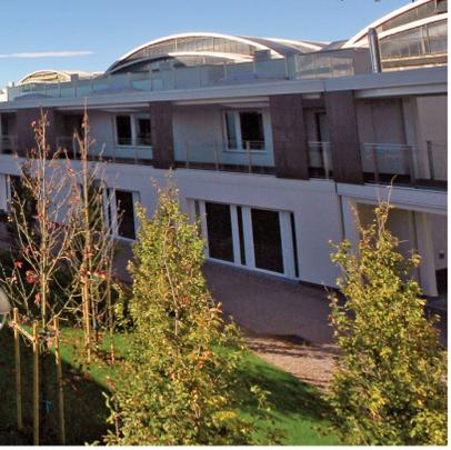
**Damit in diesem sozialen Wohn-projekt in Mailand jede Jalousie möglichst einfach mit Motorantrieb und Fernbedienung nachgerüstet sowie der Wärme- und Kälteeintrag durch sonst übliche Rollladenkästen vermieden werden kann und Wartungs-, Reinigungs- sowie Instandhaltungskosten weitestgehend entfallen, wurden hier die integrierten ScreenLine®-Jalousien eingebaut.**
