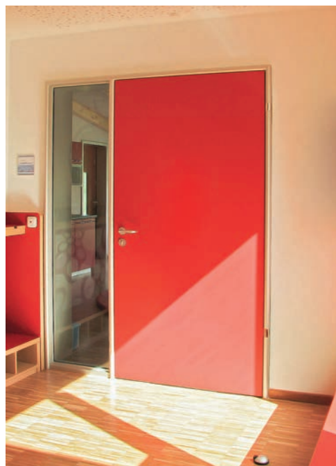
Bild 4. Küffner-Fingerschutztür als Zugang zu einem Klassenraum, eingebaut in die gerundete Fingerschutzzarge mit Glasseitenteil; integrierte Bänder und nachgiebige Bereiche an den Türkanten erhöhen die Sicherheit für Kinder im Schulalltag maßgeblich (Fotos/Grafiken 1, 3 und 4: Küffner Aluzargen)
