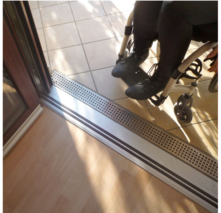
Die ALUMAT-Dichtung wurde bei Frau Heidak in einer Bestandswohnung eingebaut. Foto: Ulrike Jocham
